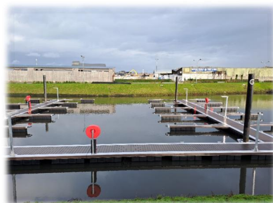
Le port de plaisance du Tréport à l'issue de la première phase de changement des pontons
