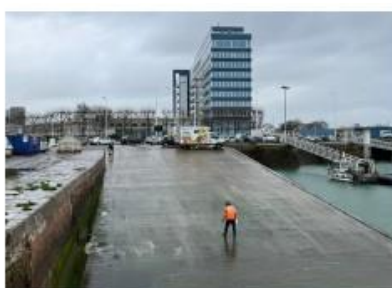
Entretien des installations Le Tréport, Fécamp, Le Havre
