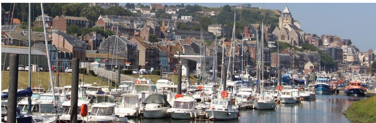
Figure 4 : vue des pontons plaisance dans le bassin pêche, de l'avant-port et du Yacht club
